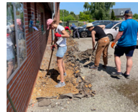
Atelier de désimperméabilisation des abords de la mairie du Troncq au cours de la formation renaturation du CAUE27.
