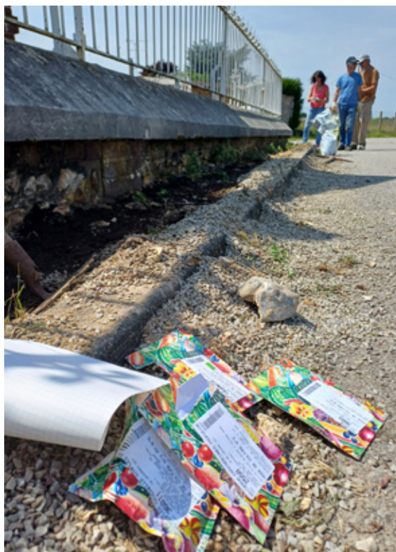
Semis de graines en pied de mur désimperméabilisé au Troncq. Formation renaturation du CAUE27.
