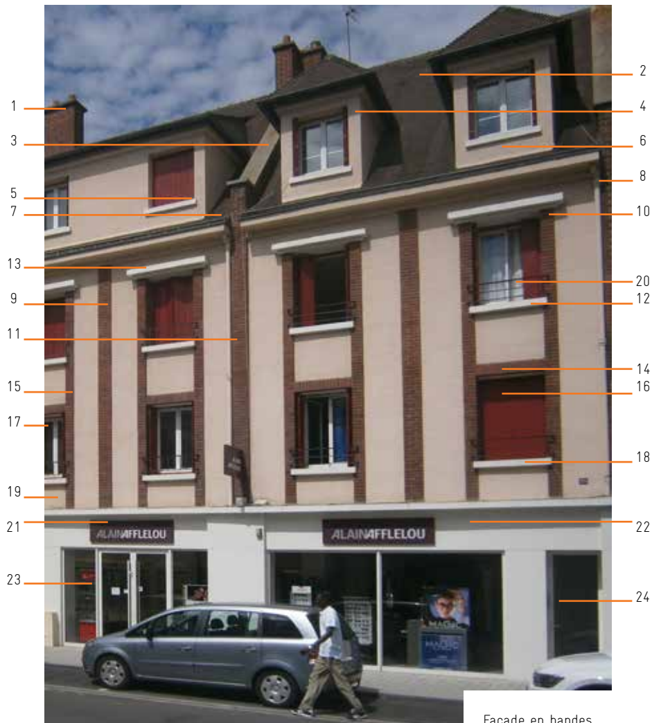
Façade en bandes
